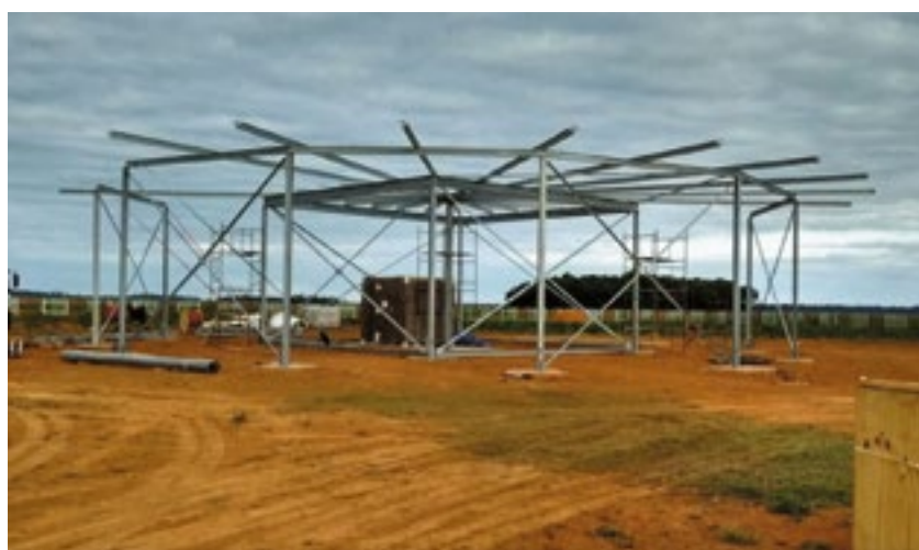
Montagem e Instalação (Vilhena)
